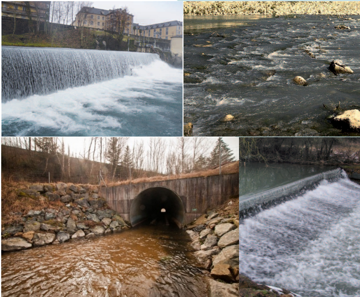
Figure 33 : Exemples d'obstacles à l'écoulement. De gauche à droite et de haut en bas : seuil vertical (Chanseau - AFB), seuil en enrochements à faible pente (Larinier - Pôle écohydraulique), passage autoroutier de type « buse » (SCIMABIO-Interface), seuil incliné présentant un redan en amont (Burgun - AFB).
